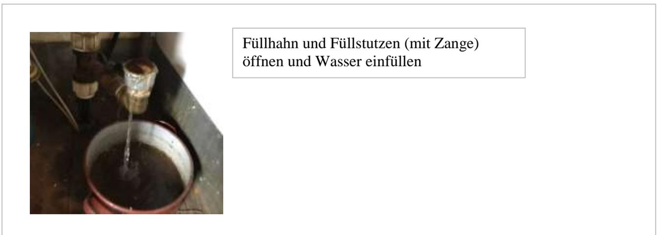
Füllhahn und Füllstutzen (mit Zange) öffnen und Wasser einfüllen
