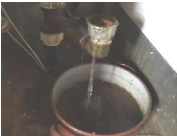
Deckel vom Füllstutzen mit Zange öffnen und den Entleerungshahn öffnen
